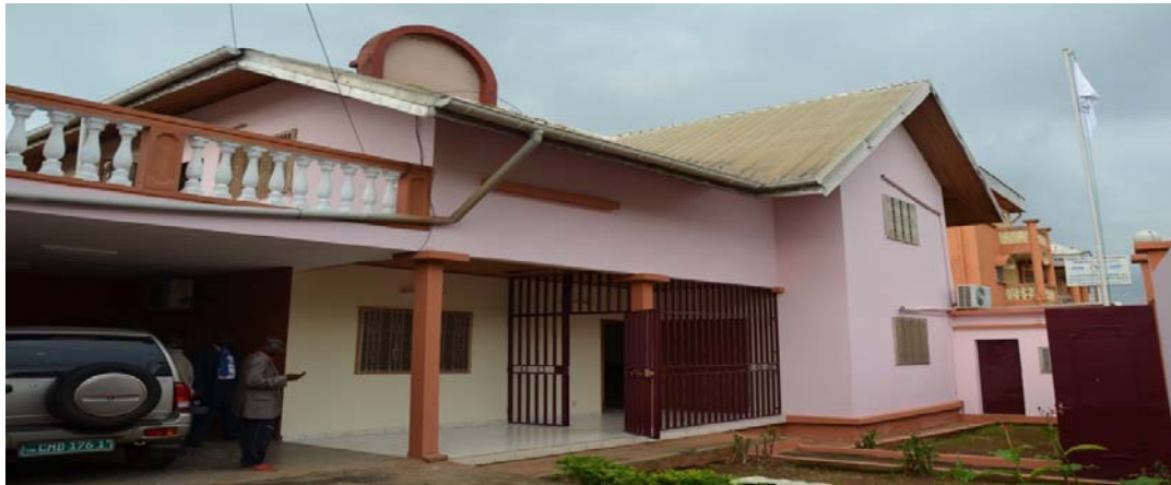
Vue de face du siège de l'UCSA
